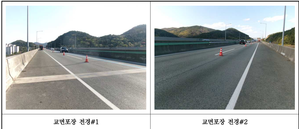
【사진 10.3.20】 교면포장 전경
