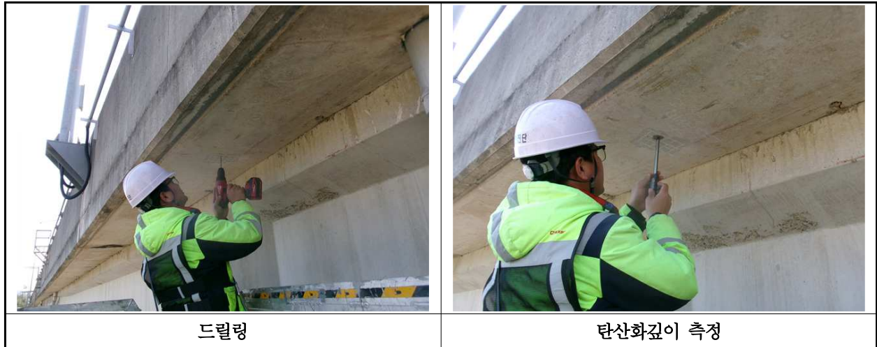
【사진 10.4.3】 탄산화 깊이 측정 현장사진
