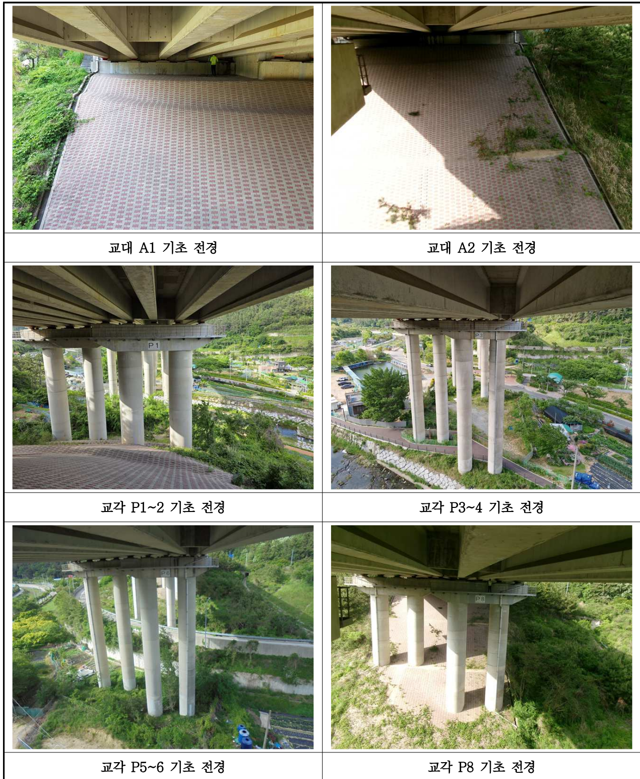
【사진 10.3.12】 기초 전경
