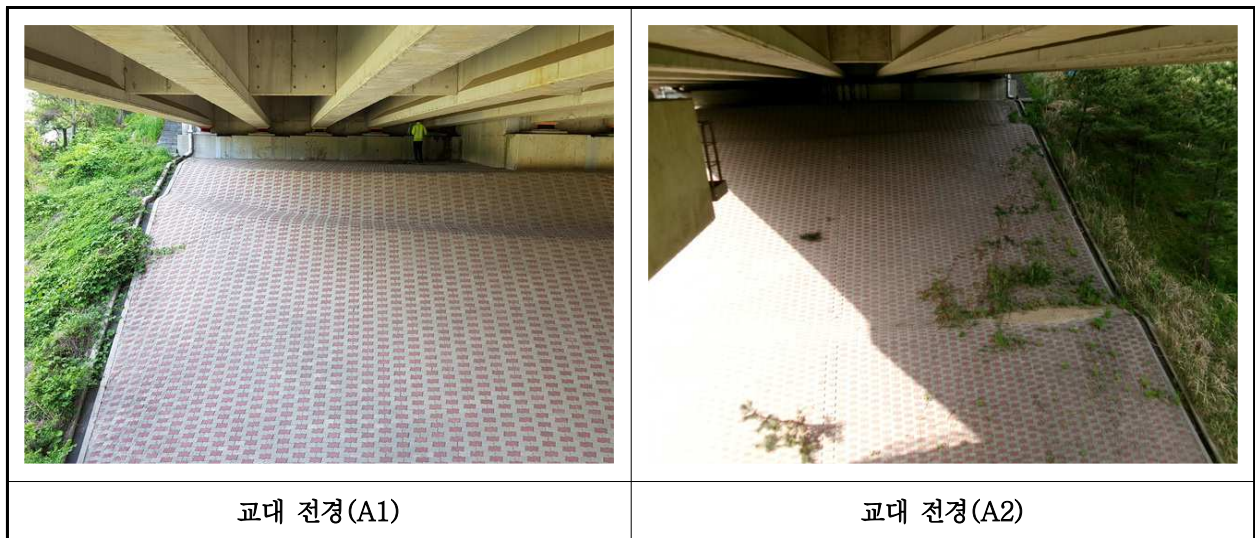
【사진 10.3.8】 교대 전경
