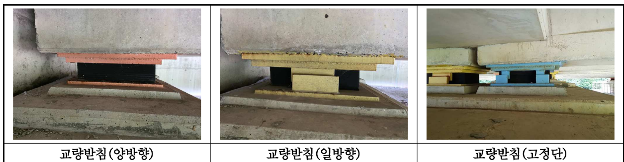
【사진 10.3.13】 교량받침 전경
