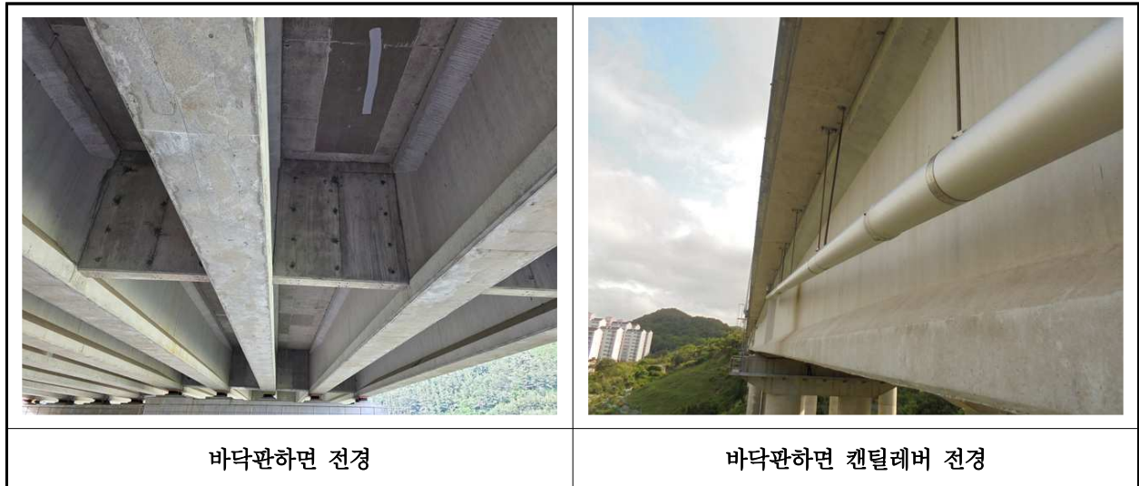
【사진 10.3.2】 바닥판하면 전경
