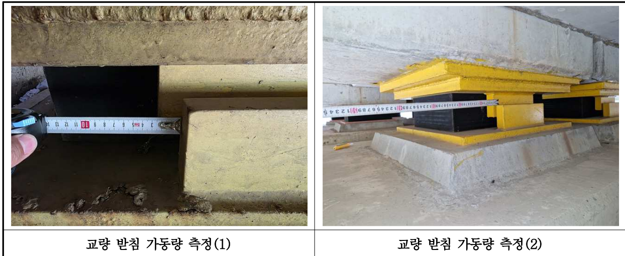
【사진 10.3.16】 교량받침 이동량 측정
