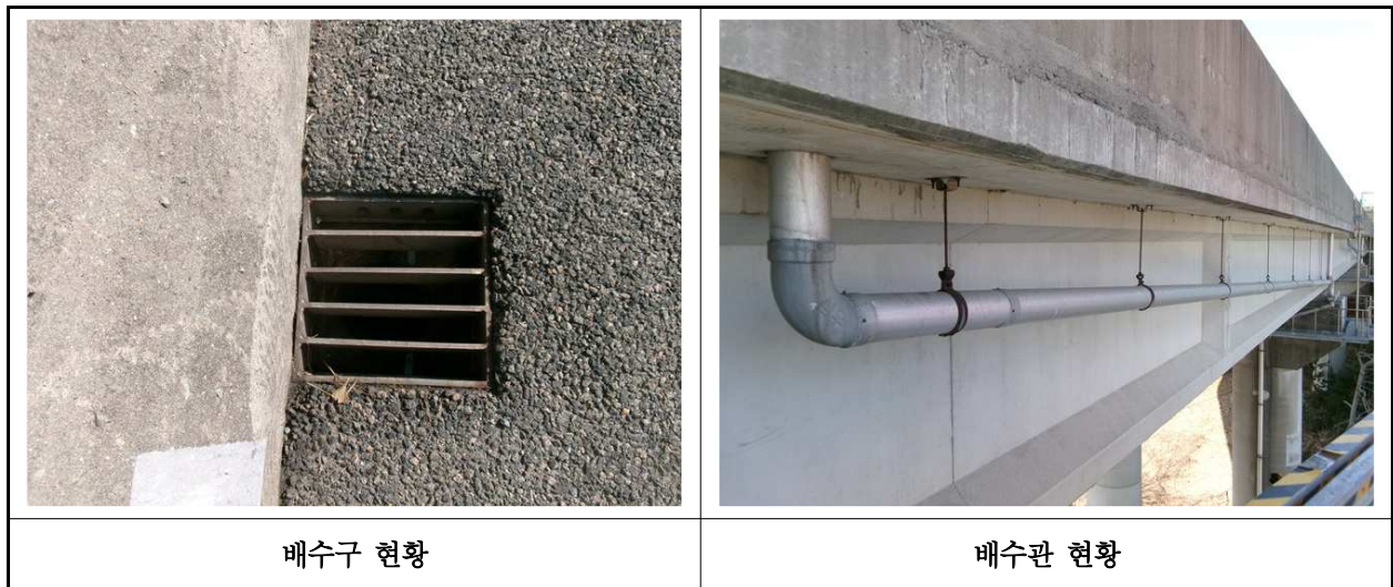
【사진 10.3.22】 배수시설 전경
