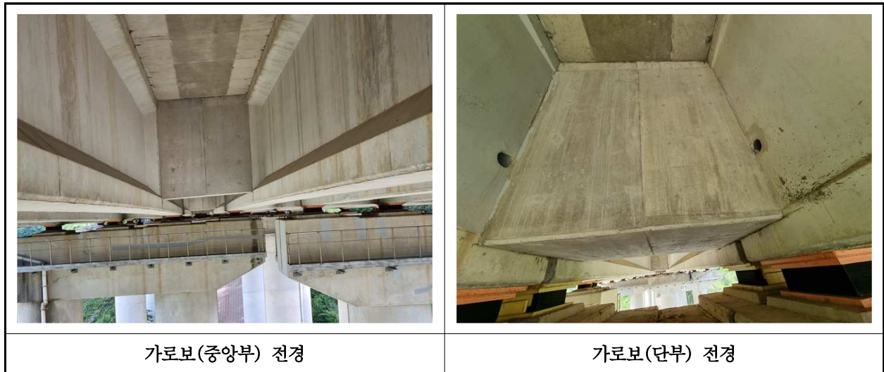
【사진 10.3.6】 가로보 전경
