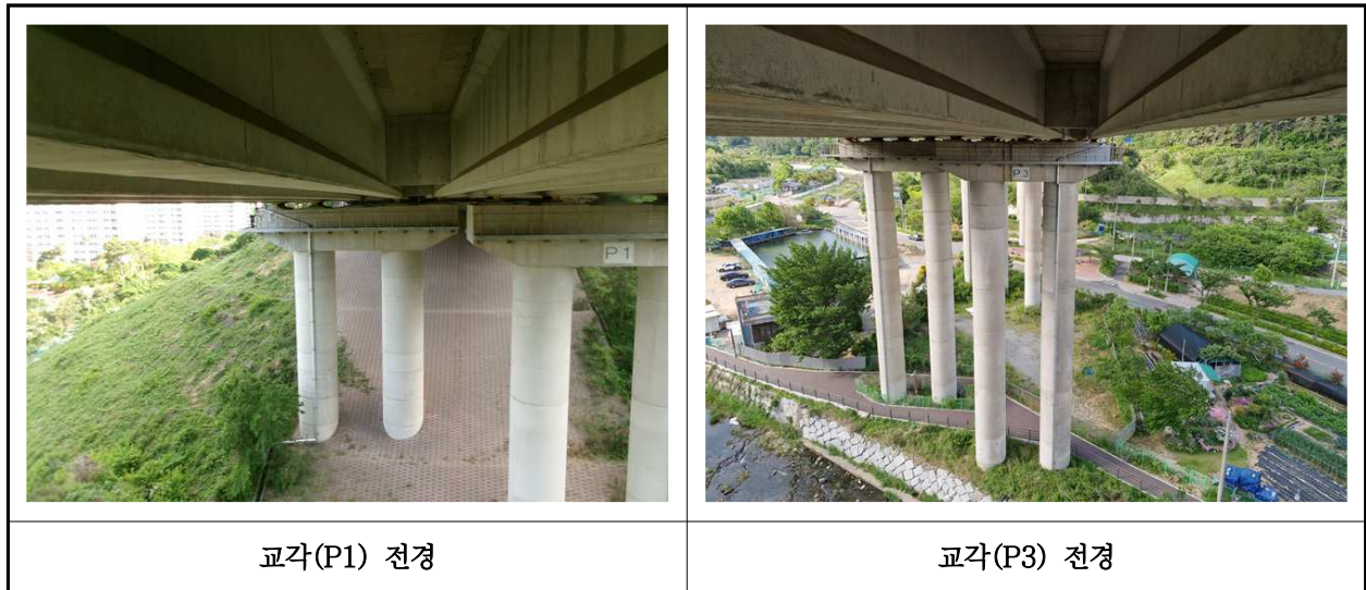
【사진 10.3.10】 교각 전경
