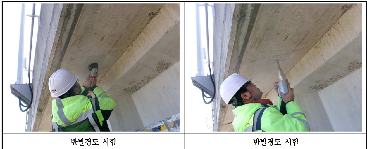
【사진 10.4.2】 반발경도시험 현장사진
