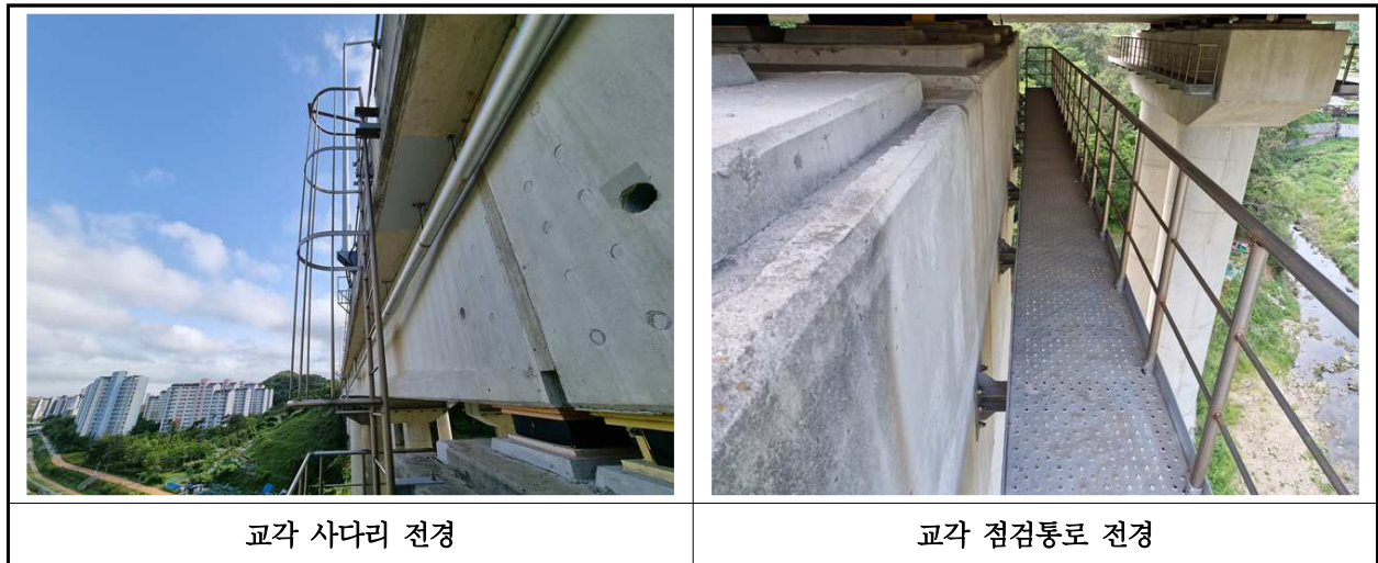
【사진 10.3.26】 교량 점검시설 전경
