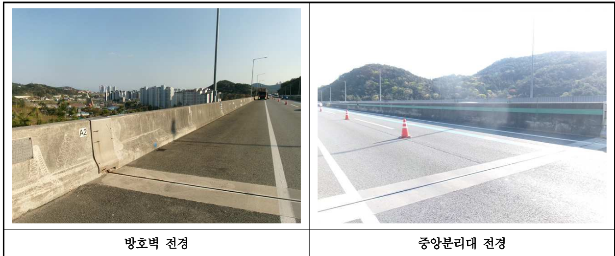
【사진 10.3.24】 방호벽 및 중분대 전경
